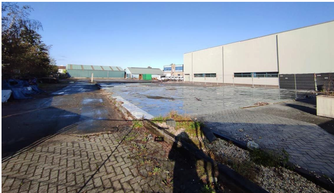
Aanzicht vanaf de Kanaalstraat (bron: Team 4 Architecten, 2021)
