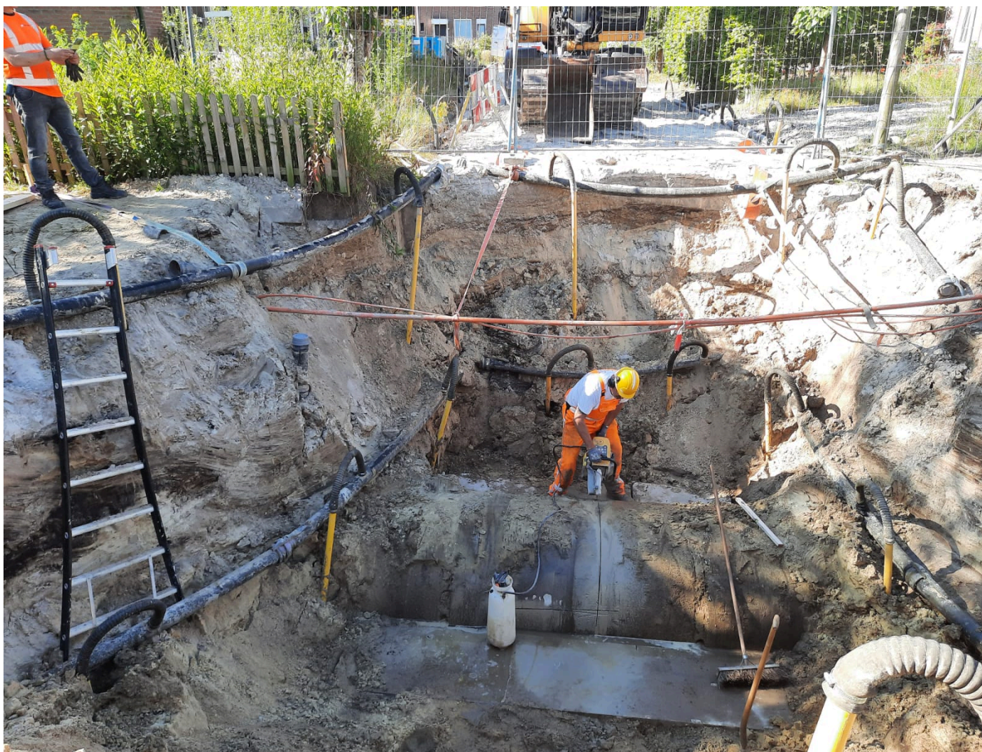
Het bestaande riool wordt open gezaagd voordat de nieuwe put er overheen wordt geplaatst om het nieuwe riool hierop aan te kunnen sluiten.
